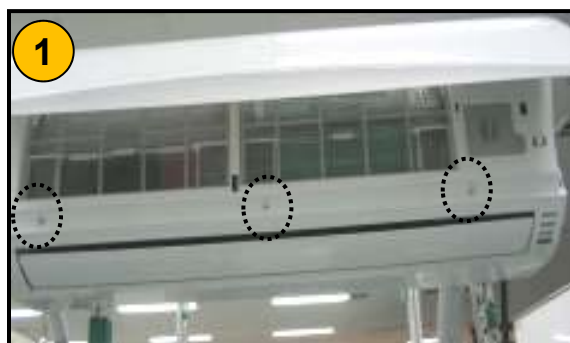
صفحه ورودی هوا را بلند کرده و 3 پیچ را باز کنید.
