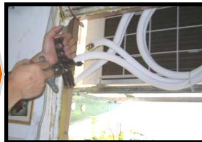
بررسی لوله کشی و فلر
